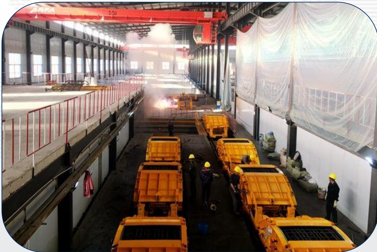
中铁一局管片流水线及模具
